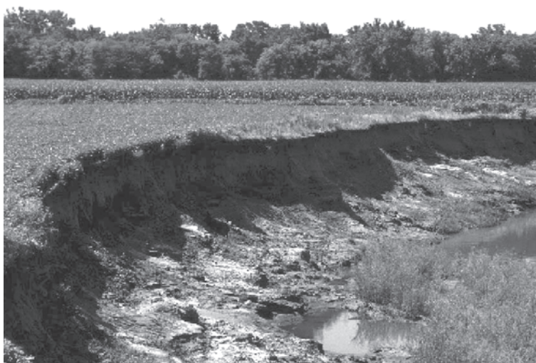
Рис. 8. Плохое состояние берегов
